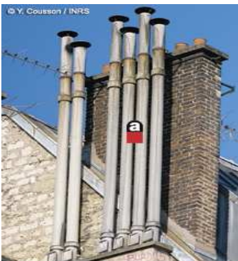
Dans les conduites en amiante-ciment (cheminée)
